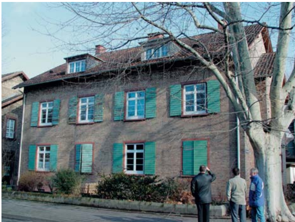
Objekt „Sodastraße 40“ vor der Sanierung
