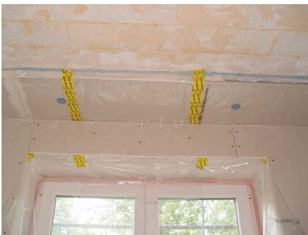
Innendämmung und Dämmschürzen mit Abdichtung
