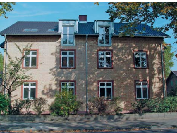
Objekt „Sodastraße 40“ heute
