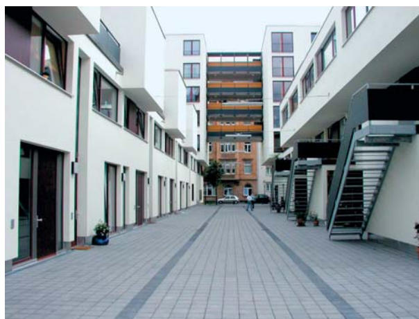
Mehrgenerationenwohnen in Mainz, Nackstraße/Leibnizstraße (Quelle: Wohnbau Mainz GmbH)
