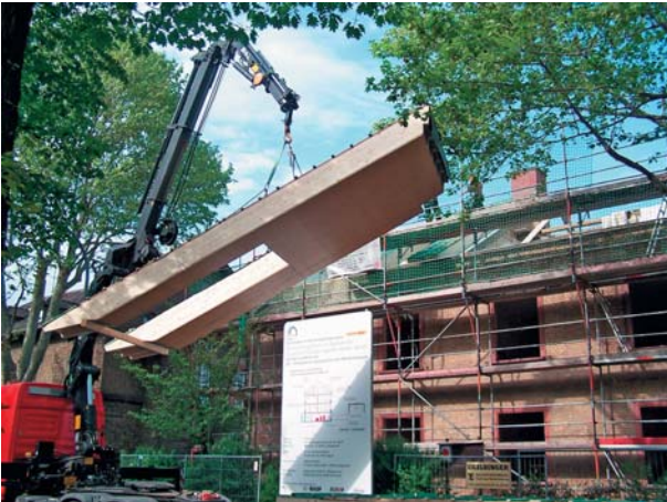
Vorgefertigte Dachelemente mit 40cm Neopor®-Dämmung
