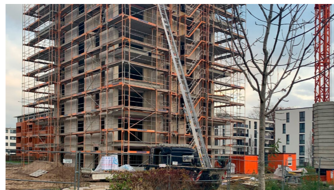
Momentan noch im Bau: Haus Nr. 7
