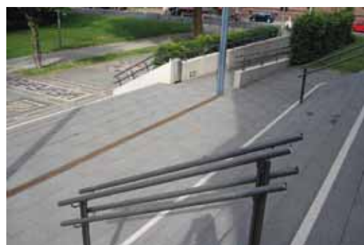
39 Handläufe in unterschiedlichen Höhen sorgen für zusätzlichen Komfort.
