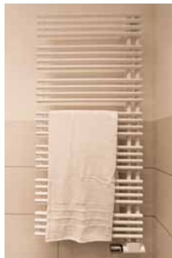
74 Handtuchheizung mit höher montiertem Ventil
