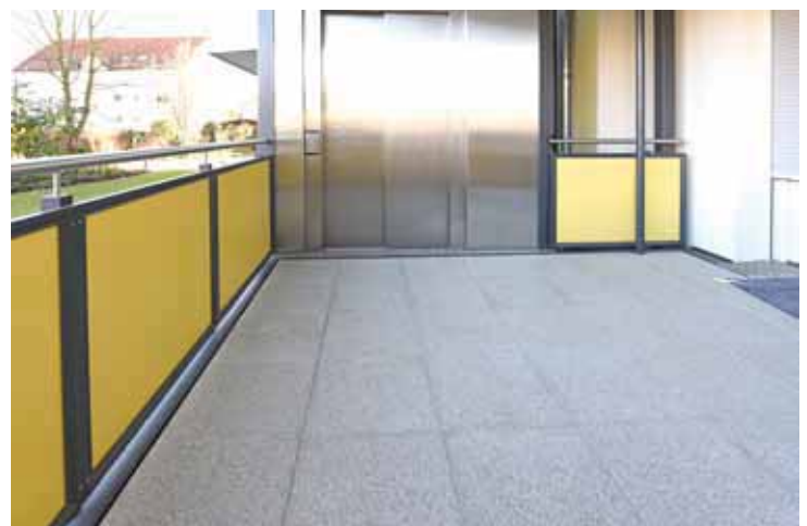
94 Schwellenloser Übergang zum Freisitz von einem angebauten Aufzug
