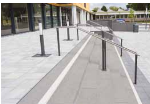
38 Mehrere Handläufe bieten bei breiten Treppenanlagen mehr Sicherheit.
