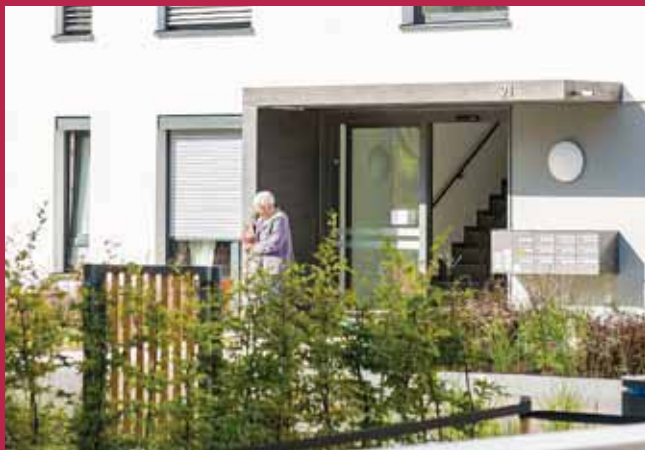
121 Hauseingang mit elektrischer Schiebetür
