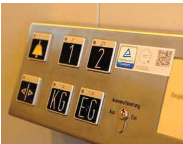
148 Barrierefreier Aufzug mit Befehlsgebern nach dem Zwei-Sinne-Prinzip
