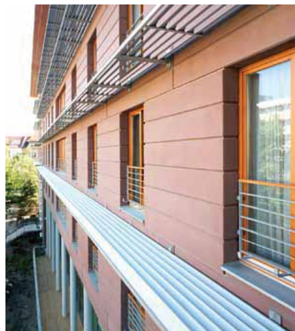
49 Metallgeländer als Absturzsicherung
