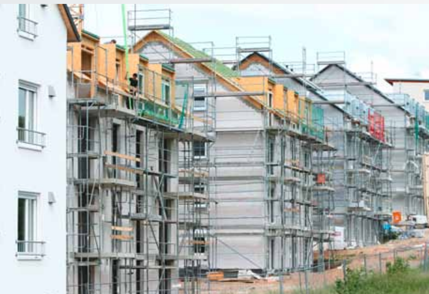
Oben: Privatinvestor Dr. André Michels (links im Bild) und Friedolin Winter, Gesellschafter der WK innovatives Bauen // Unten: Schon in der Bauphase erhält der Gesellschafter für seine Neubauten zahlreiche Anfragen potenzieller Mieter.
