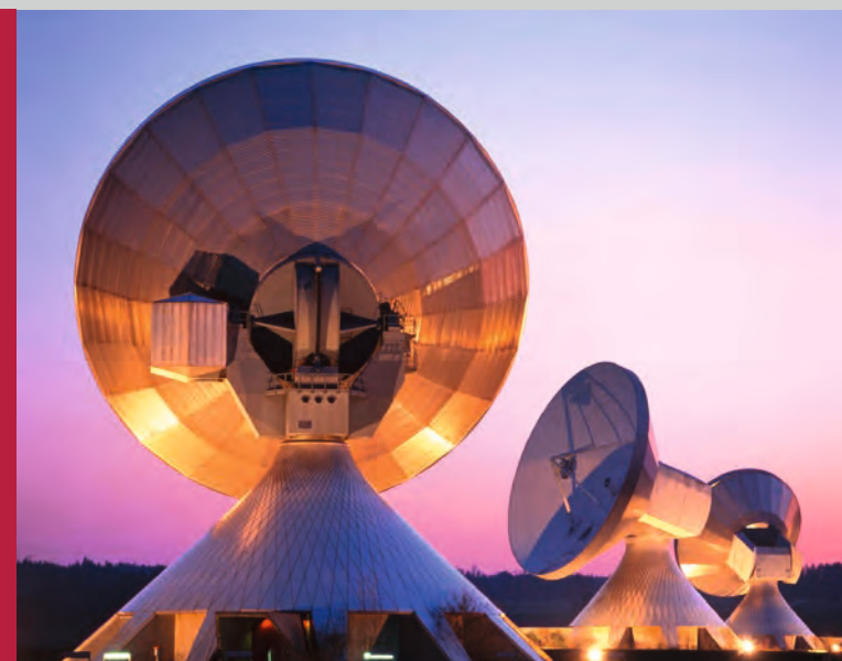
Satelliten Erdfunkstelle. MT Mechatronics GmbH - Die Firma hat ihren Sitz in der rheinland-pfälzischen Hauptstadt Mainz.
