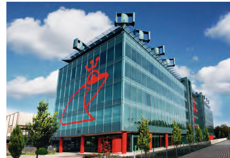
Das neue Verwaltungsgebäude des Mainzer Familienunternehmens Werner & Mertz (bekannt durch die Marken Frosch und Erdal). Besonderheit: Durch Photovoltaik erzeugt das Haus mehr Energie, als es verbraucht.
