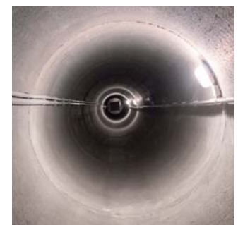
Innenansicht eines Erdkollektors zur Außenluftversorgung am Umwelt-Campus Birkenfeld
