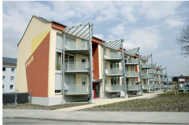
Passivhaus Hoheloostraße 1 – 3, Ludwigshafen (Quelle: GAG Ludwigshafen am Rhein)
