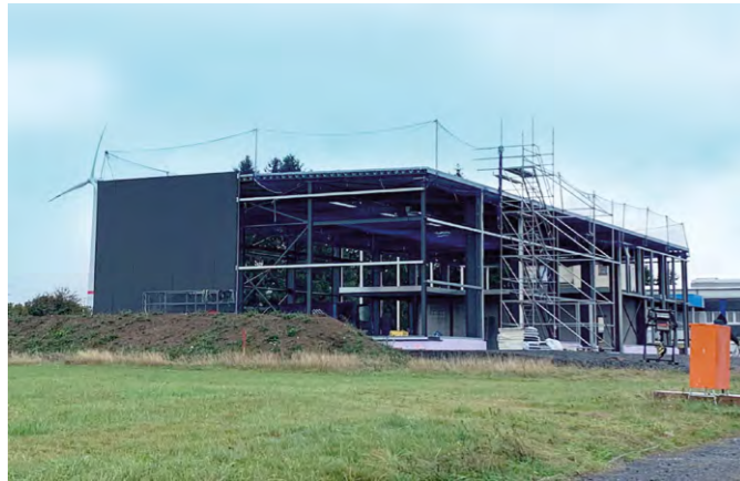
Hier entsteht die neue Produktionshalle – und gleich daneben eine Blumenwiese
