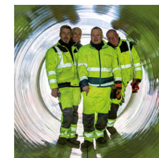
Geschafft – ein mannhoes Rohr wurde erneuert
