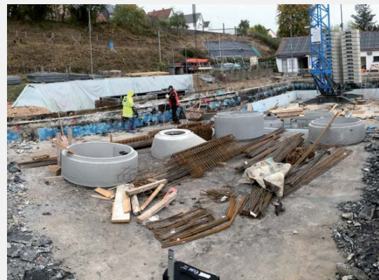
Baustelle: Das Schwimmbad war in die Jahre gekommen
